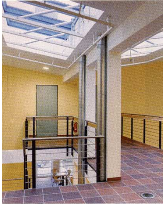
Obergeschoss mit Lichtkuppel/RWA.
