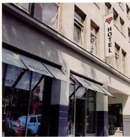
Nach dem Umbau 1999/2000: CVJM e.V. Düsseldorf
